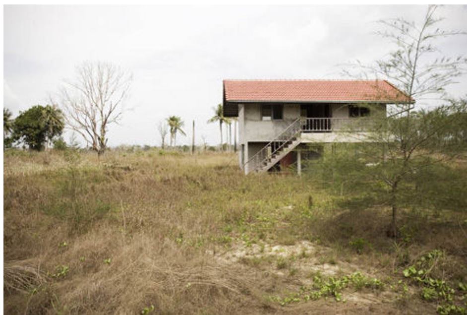
Leerstehendes Haus in Thung Dhab, finanziert durch Deza und Glückskette im Projekt Rehabilitation von Fischergemeinden in Thailand.
