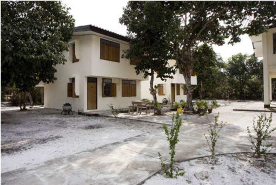
Die Personnhäuser des Gesundheitszentrums sind unbenutzt.
